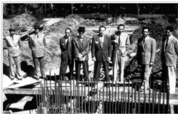
Figura 14 – Belo Horizonte, 1943: o prefeito Juscelino (chapéu preto) visita obras da Pampulha. A seu lado, gravata escura, o arquiteto Oscar Niemeyer.
